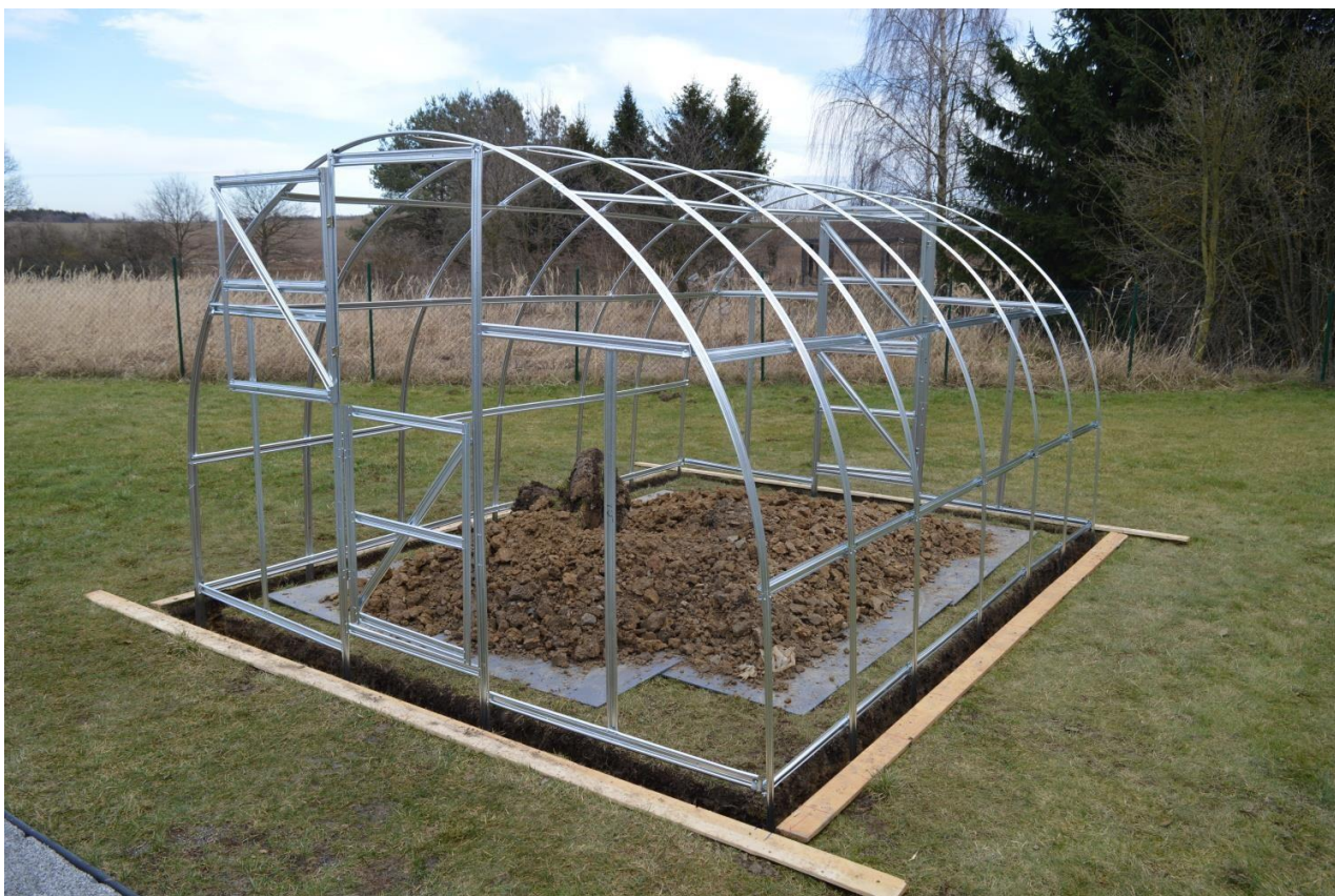
Illusztrációs fénykép a földbe történő rögzítés módjáról (az egyes profilok elhelyezkedése eltérhetnek az üvegház modelljétől, méretétől és gyártási évétől függően)
